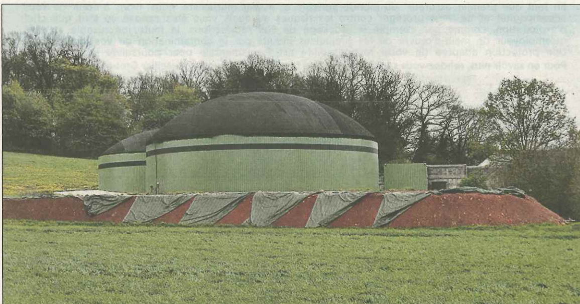
La méthanisation consiste à faire fermenter la biomasse en milieu anaérobie afin de libérer du gaz qui alimente un générateur d'électricité.
